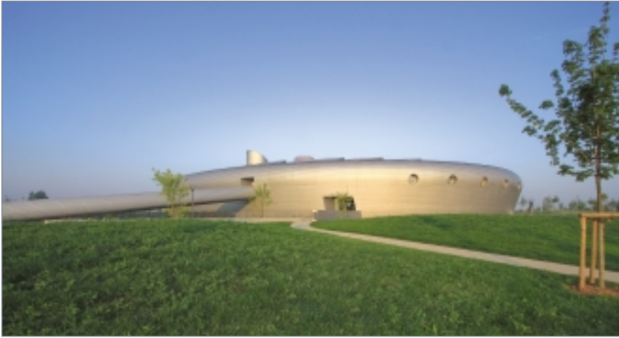
■ Das Bad „Les Thermes“ der Architektengemeinschaft Jim Clemens / wity & wity / Hermann & Valentiny von außen; Foto: Les Thermes, Strassen-Bertrange, Luxemburg
