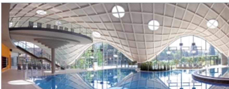
■ Toskana Therme, Bad Orb (Architektur: Ollertz Architekten BDA, Fulda; Tragwerk: Trabert + Partner, Geisa): Außenansicht (oben) und Innenansicht der druckbeanspruchten Holzrippenschale; Fotos: Ollertz Architekten, Fulda
