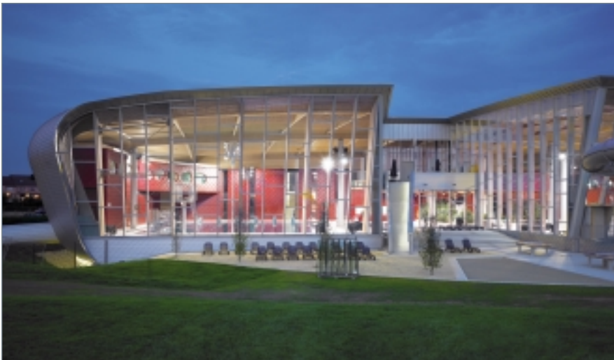
■ Les Thermes: Blick von außen nach innen ...
